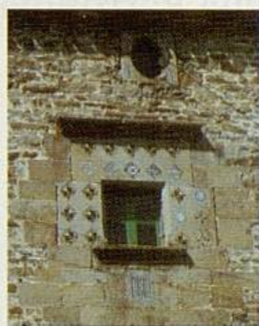
DETALLE DE LA TORRE DE LOS AZULEJOS
