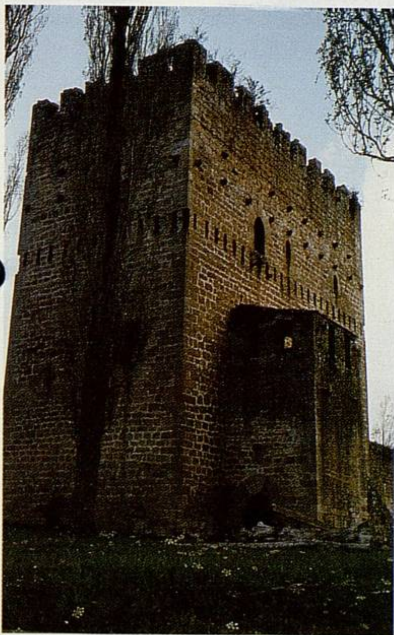
TORRE DE LOS VELASCO
